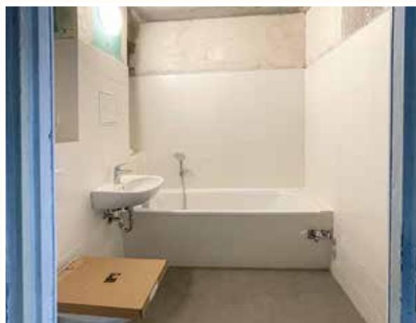
Zeitgleich können Maler und Fußbodenleger mit der Renovierung beginnen. Die Wände werden mit Raufasertapete beklebt und mit weißer Farbe gestrichen. In der gesamten Wohnung wird PVC in Laminatoptik verlegt. Sind all diese Arbeiten durch Fremdfirmen abgeschlossen, wird in der Regel unser Sanitär-Handwerker das Bad komplettieren. Waschbecken, Toilette, Waschmaschinenanschluss und sämtliche Armaturen werden installiert.
