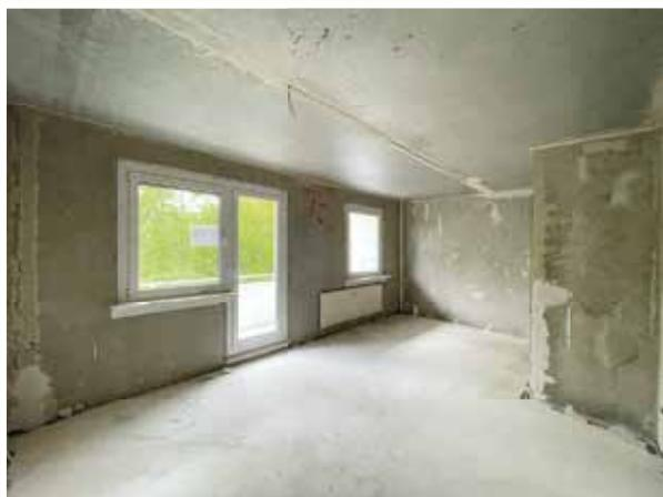
Zunächst entfernen der Fußbodenleger und der Maler den alten Fußbodenbelag und die alte Tapete. Zeitgleich werden durch unseren betriebseigenen Handwerker die Rauchwarnmelder und Beschläge demontiert.
