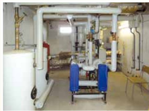
Heizstation - Am Försterweg
