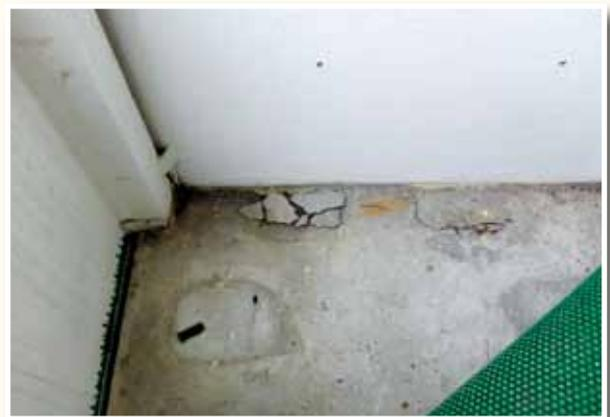
Untersuchungen der Balkonschadstellen auf etlichen Balkonen führten zu dem Ergebnis, dass es notwendig ist, die Balkone entweder komplett und intensiv zu sanieren oder zu erneuern.
