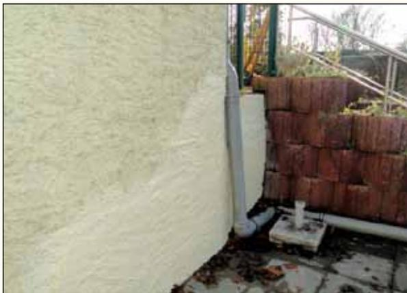
Der bröckelnde Putz an der Hausfassade (Hofseite) und an den Mauern im Gartenbereich wurde ausgebessert und malermäßig instandgesetzt. In Kürze folgt noch die Putzausbesserung am Schornstein auf dem Zugang zum Dachboden.
