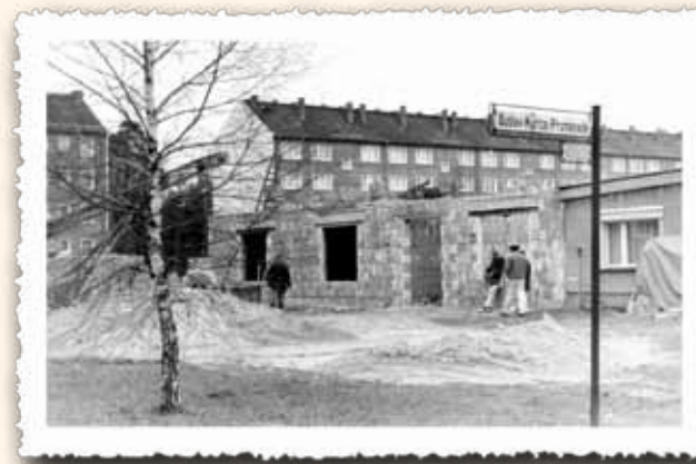
Anbau von mehreren Räumen an das Verwaltungsgebäude in der Gustav-Kurtze-Promenade 80
