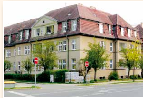
Dachsanierung August-Bebel-Straße/Elisabethstraße vorher ...
