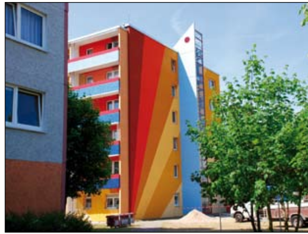
Nach der Rekonstruktion und Wärmedämmung
